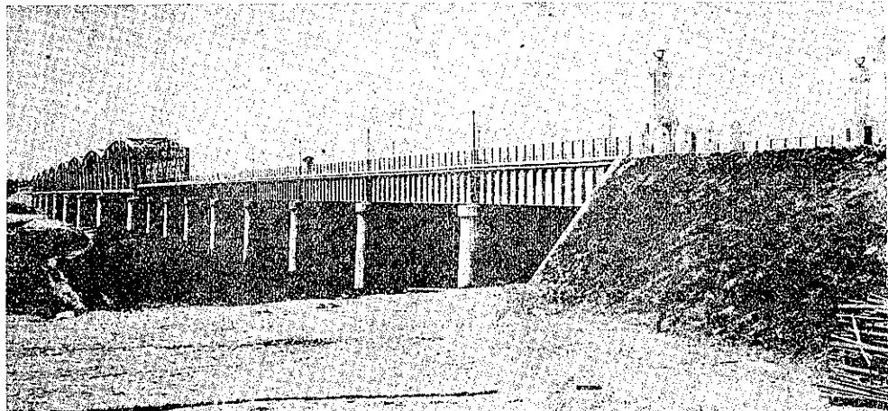
延長 九百八十三米 有效幅員 七米半 構造 鋼筋桁架間二十米…二十四連
