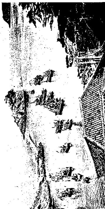
防波堤延長 79 尺、天端幅 3 尺、高さ 低水面上 7 尺
