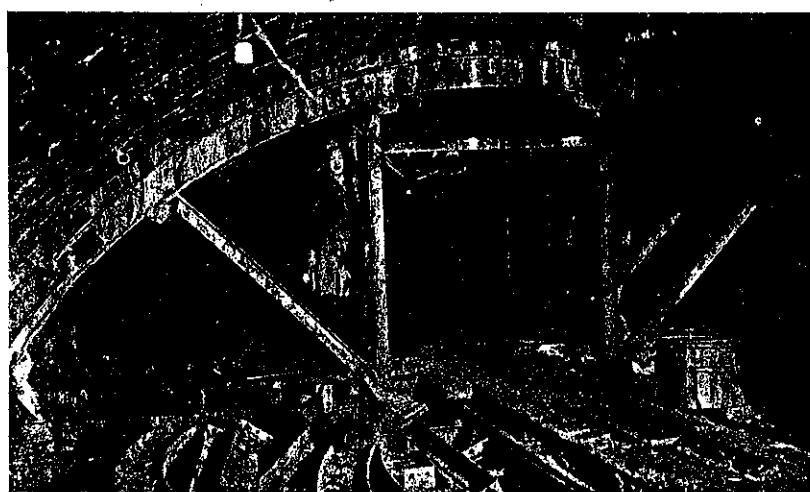
← 热海口型築用鐵製脚架
