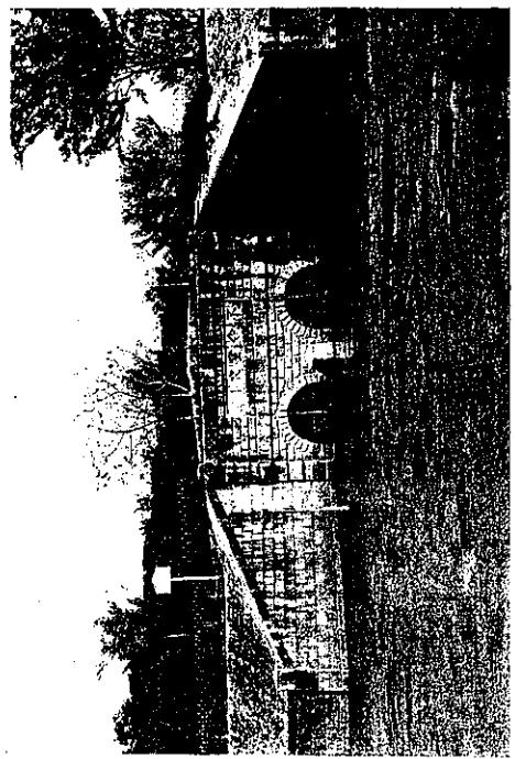
115 人口 160,000 人に対する最大給水量 16,990 立方米を有し得、其の構造は石造圓門形、此配水管内徑 1.8 吋を布設し貯水池に入る合併 3 個を繋合して貯水池に入る
