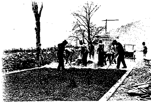
アスファルト混凝土布設
