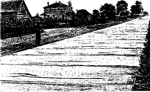
混凝土道撒水養生法
