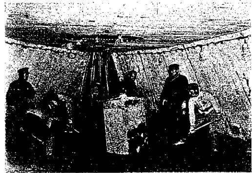
潜函内掘鑿 (バケットの上方潜函天井中に堅管の下端見ゆ)
