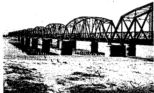
完成せる木曾川橋梁 (桁桁 200 呎 13 連及 120 呎 1 連 昭和三年六月一日開通)
