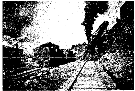
110-C 型 ショベル山地掘鑿の状況
