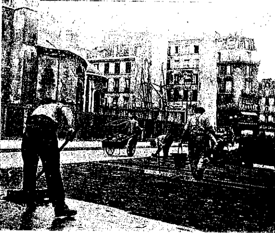
巴里市内木塊舗装工事の状況
