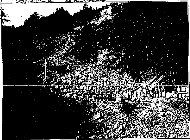
寫真第六 多摩川筋枋久保澤堰堤工事
