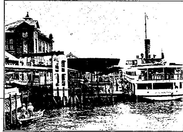
關門連絡—旅客連絡設備下關棧橋
