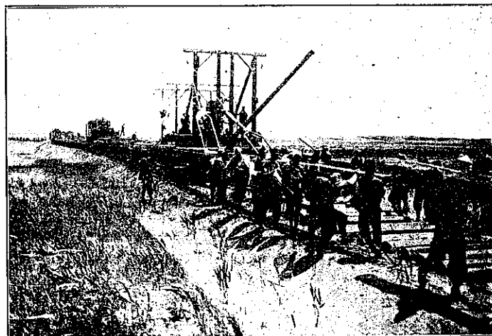
枕木轉送機の先端迄送り出されたる枕木を擔いで運搬する光景
