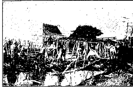
沈床 竣功せる第四號橋脚根固 寫眞第三十
