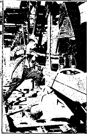
寫眞第五十一 100呎トラス、リベット打
