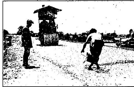
寫眞第三十四 アスファルト撒布
