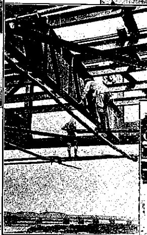
寫眞第五十 100呎トラス、ペイント塗
