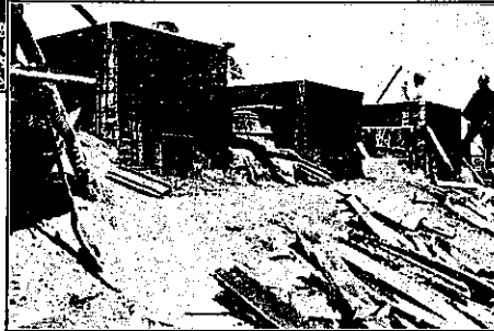
寫眞第三十三 鋪裝用アスファルト窠
