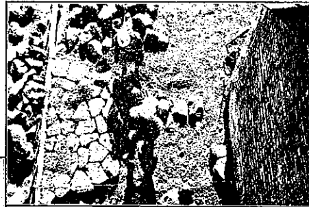
寫眞第三十一 第六號橋脚根固石張
