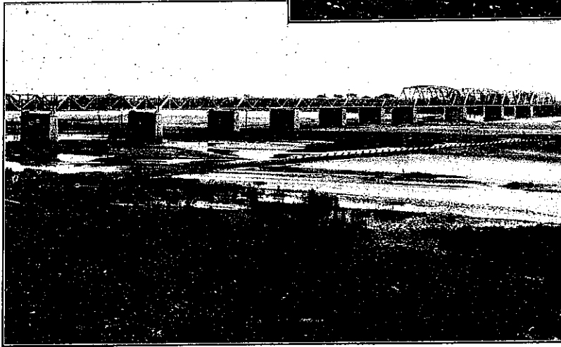
寫真第二 左岸より見たる 100 呎鋼構
