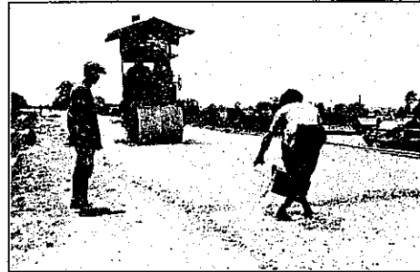
寫眞第三十四 アスファルト撒布
