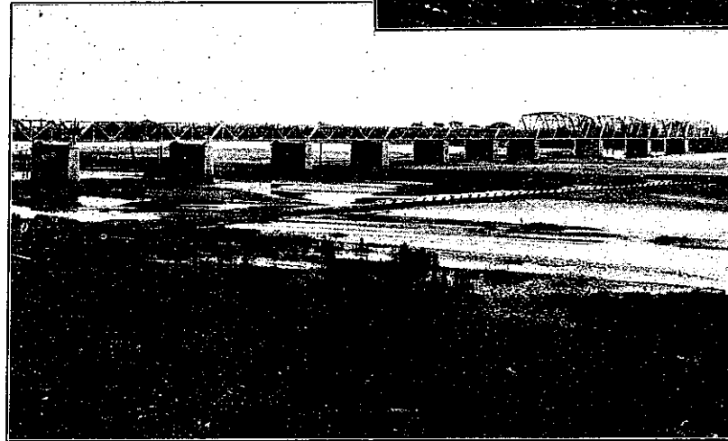
寫眞第二 左岸より見たる 160 呎鋼構
