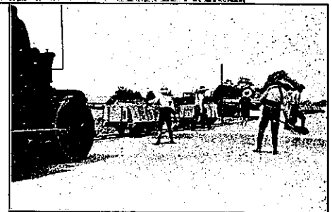
寫眞第三十五 アスファルト撒布後の輾壓
