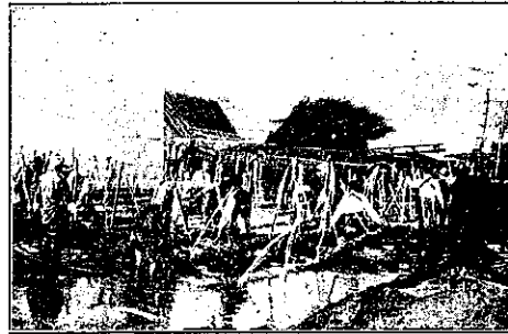
沈床 竣功せる第四號橋脚根固 寫眞第三十
