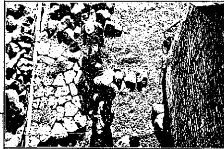
寫眞第三十一 第六號橋脚根固石張
