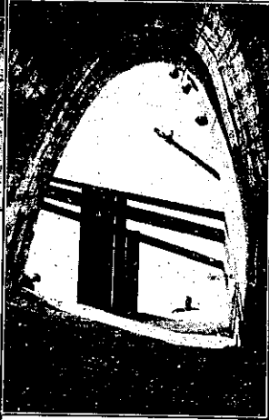
寫真第十六 水管後底面より上部を 仰ぎたる橋臺井筒
