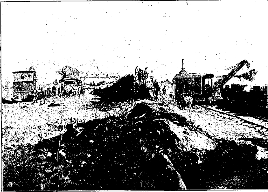
高臺地にショベル及梯形掘鑿機操業
