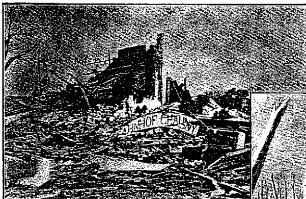
寫真第二 破壊サレタルしよーに-停車場本屋
