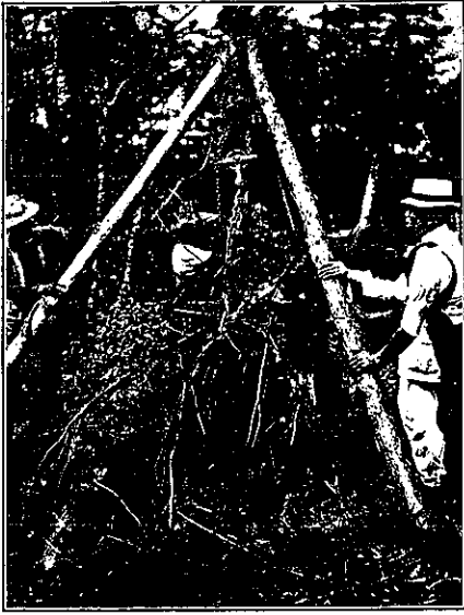
寫真第十 伐根掘取
