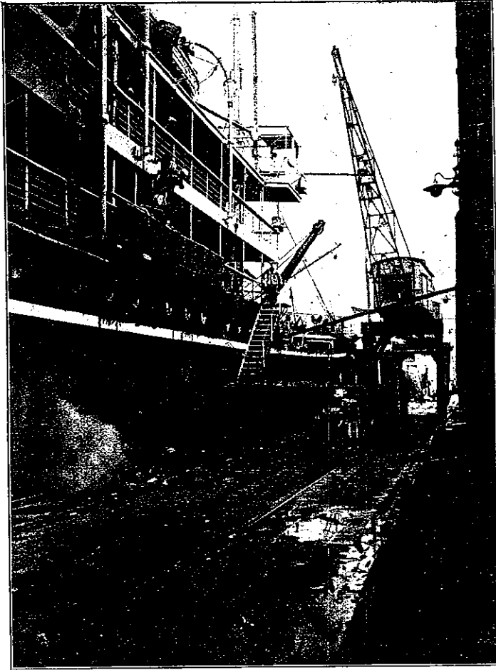
電氣起重機ノ本船荷役
