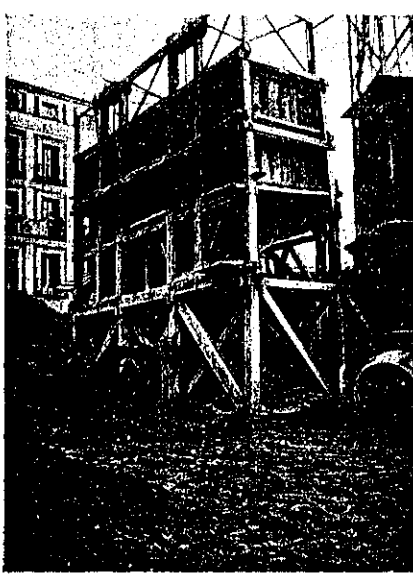
寫真第九 堅坑土砂溜
