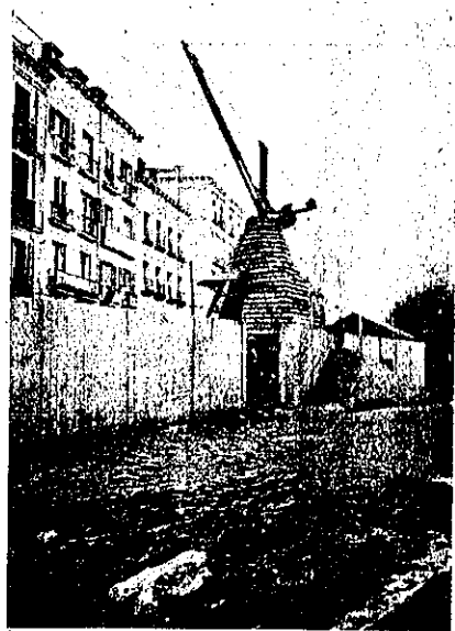
寫真第七 堅坑及ビ電氣くれーん
