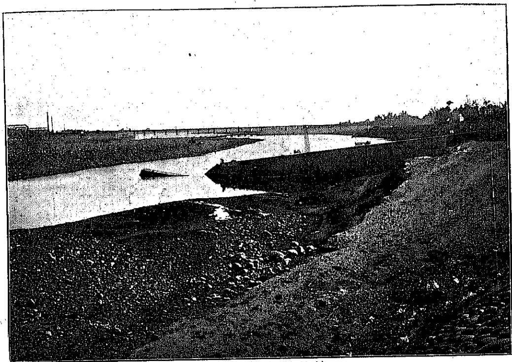
(前寮薯蕃)溪仙梓楠 フ向ニ流下リヨ(とーりくんこ)工水制一第
