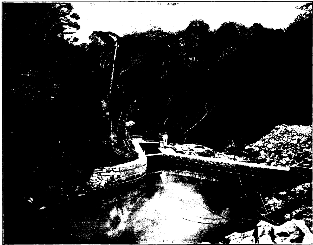
大河間發電所水路取入口堰堤
