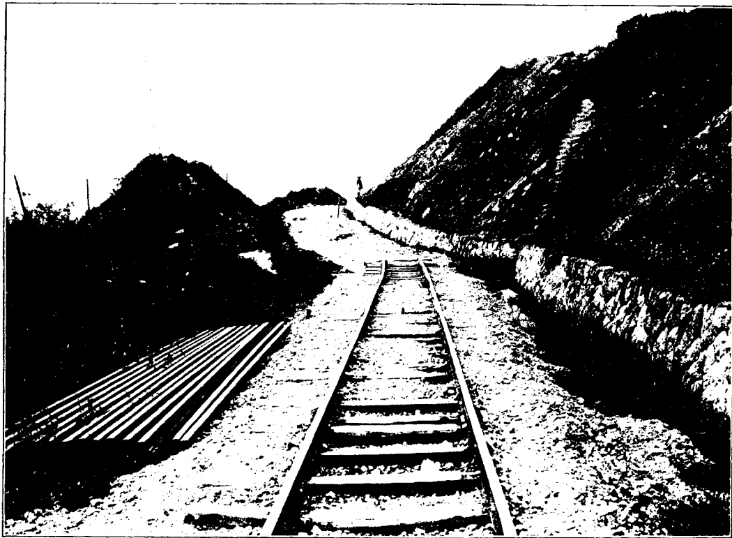
明治三十八年八月三日寫 明治三十八年下諏訪山崩れ（南側より見る）地質學雜誌百四十三號を見よ
