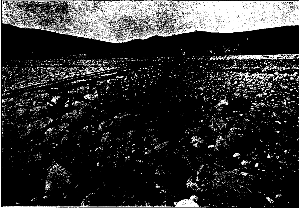
大 安 溪 (附輕便鐵道用木橋)
