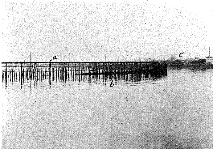
寫眞2. 吸ひ揚げたる土砂を埋立目的地迄流送する送砂管路と土留用假木柵 a, 送砂管路、b, 假木柵、c, 後方地域たる品川区大井北濱川町附近
