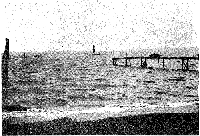
寫眞14. 矢印箇所の木柱に沿つて左右に延びてゐる線は一號埋立地西側に護岸用方塊一段を敷設した所。
