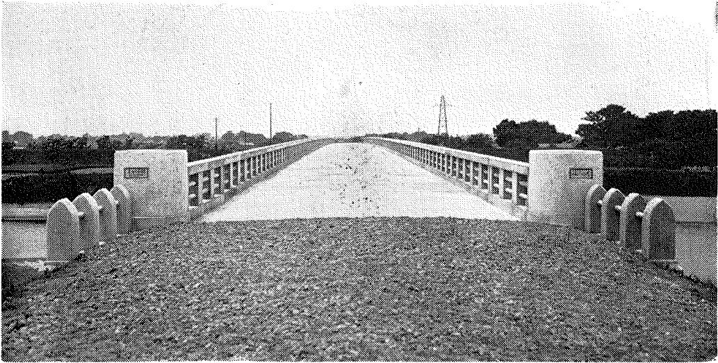
写真 1. 開通式を待つ鬼怒川橋
