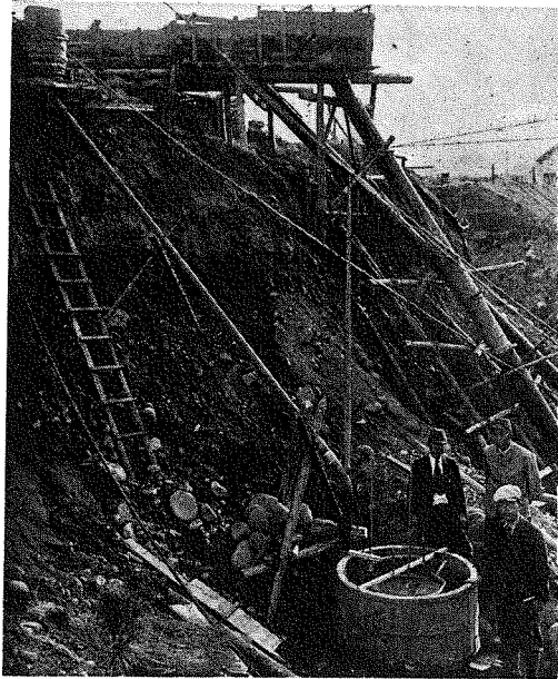
写真 1. 水勢調整槽の模型実験設備。
