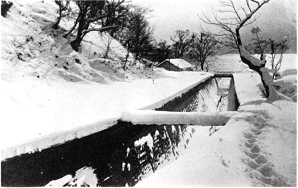
寫眞 3. 玉川取水路（田澤湖注水口附近）。
