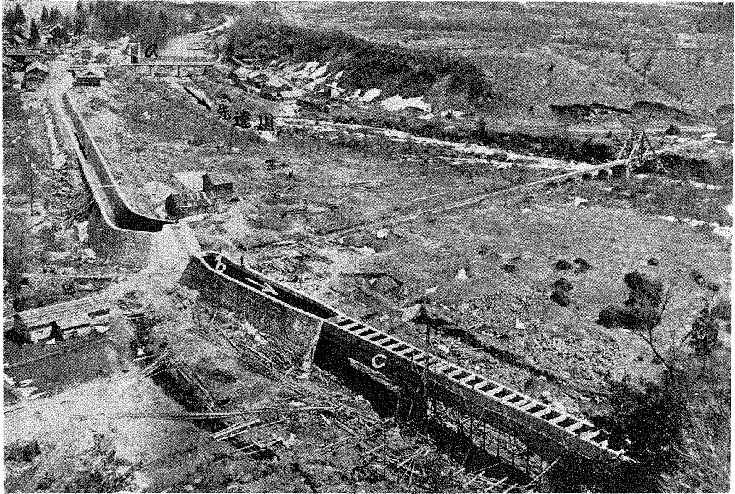
寫眞 5. 先達川取水路 a, 堰堤及取水口 b, サイフォン c, 水路橋。
