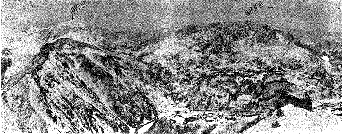
寫眞 1. 眞那板山隧道の遠望。
