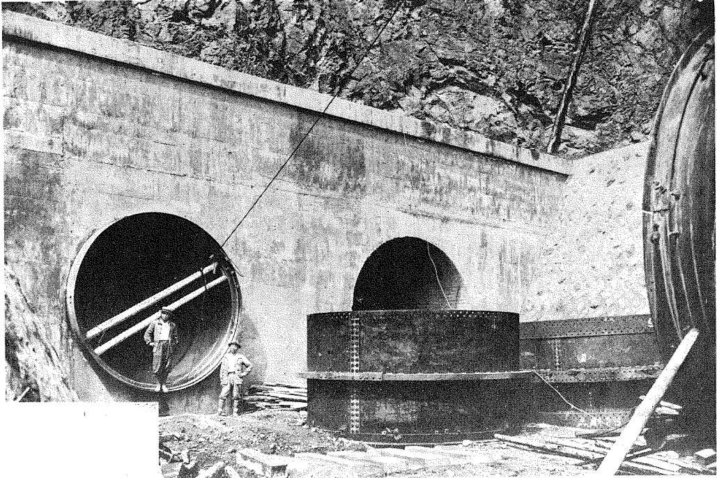
寫真27. 鐵管隧道出口(昭和14.6.27)
