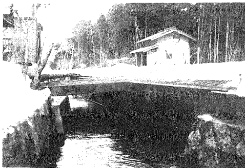
寫眞1. 竹筋コンクリート版橋。
