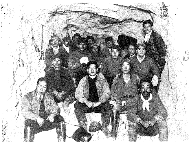
寫眞16. 第5號隧道貫通 (13. 12. 22)
