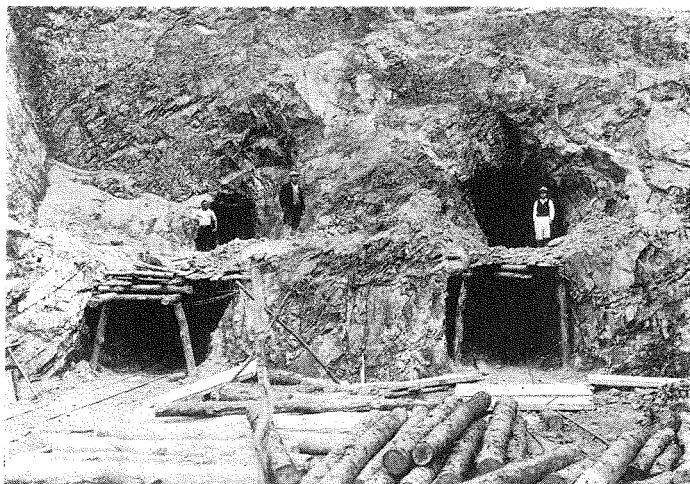
寫眞17. 鐵管隧道坑口 (13. 6. 6)
