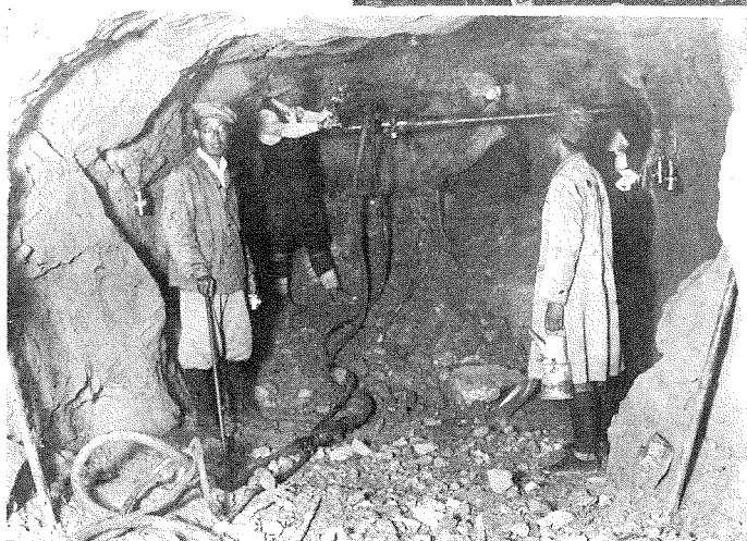
寫眞6. 第2號隧道下口導坑 (13. 7. 21)
