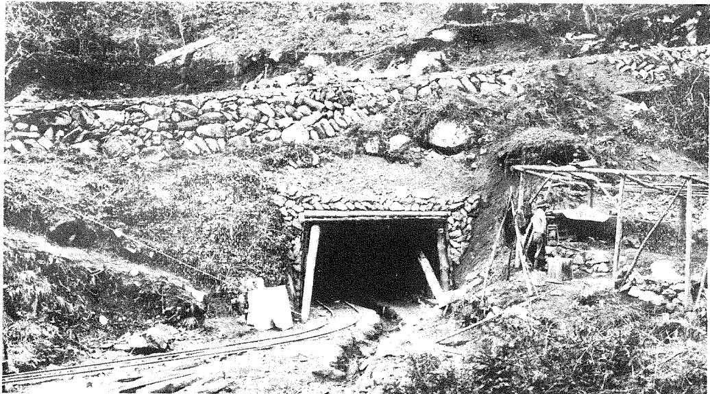
寫眞 3. 第 1 號 横 坑 口 (12.10.31)
