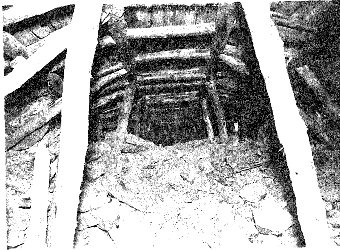
寫眞14. 第4號隧道切擴並に 支保工(13. 7. 26)
