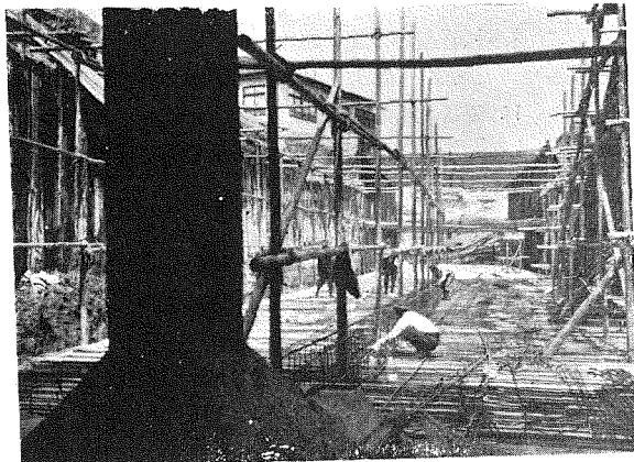
寫真1. 廣場下、中柱式函型構築下床配筋。
