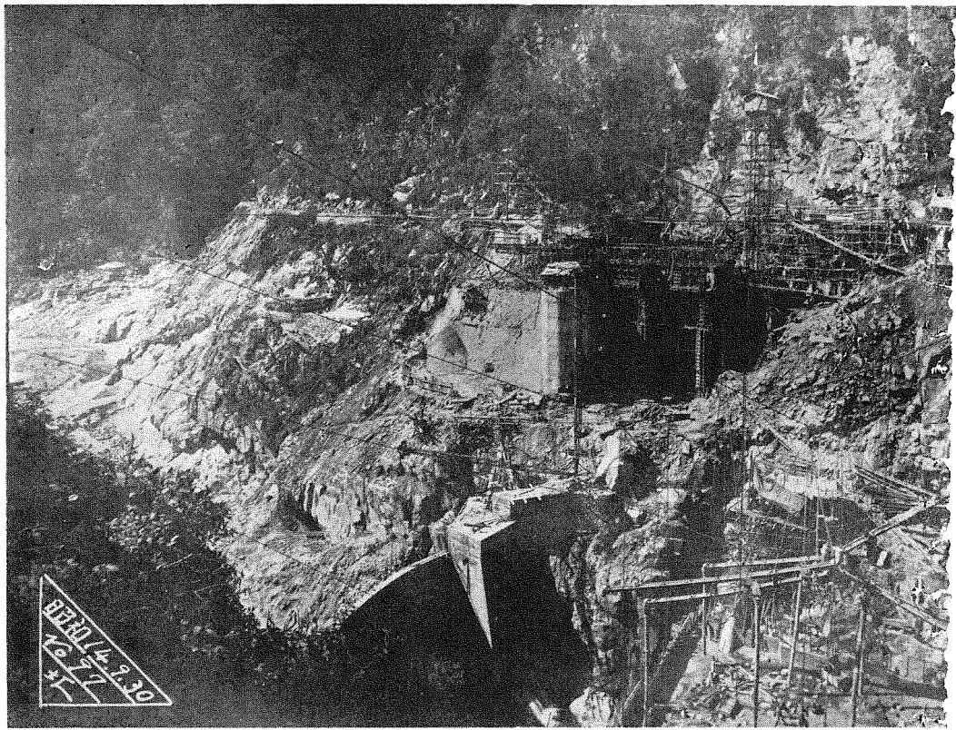
1. 堤附近。左端拱堰堤は第2假締切。其の上部は取水口（之の奥に續いて沈砂池あり）堰堤下流タワー附近はミキシング・プラント。
