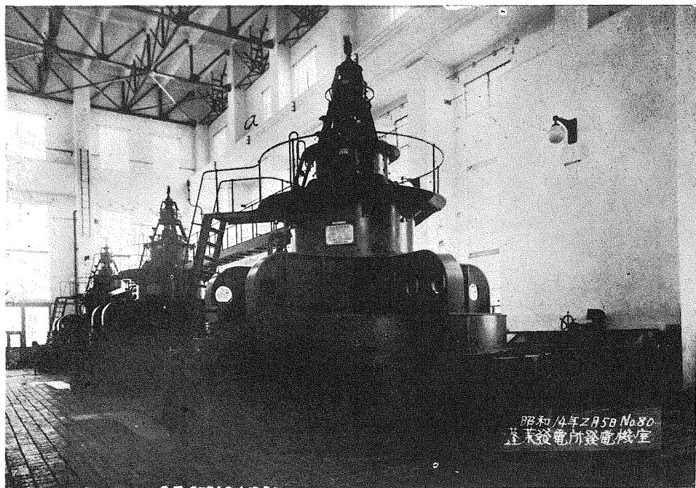
写真15. 発電機室。起重機移動橋
