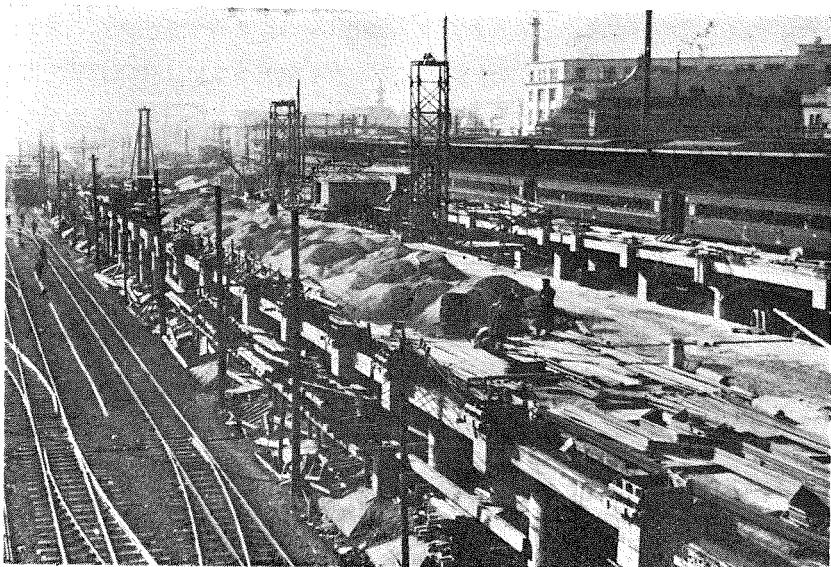
写真1 神田驛より有樂町側を望む。左側3線3柱式高架橋、右側1線2柱式高架橋。
