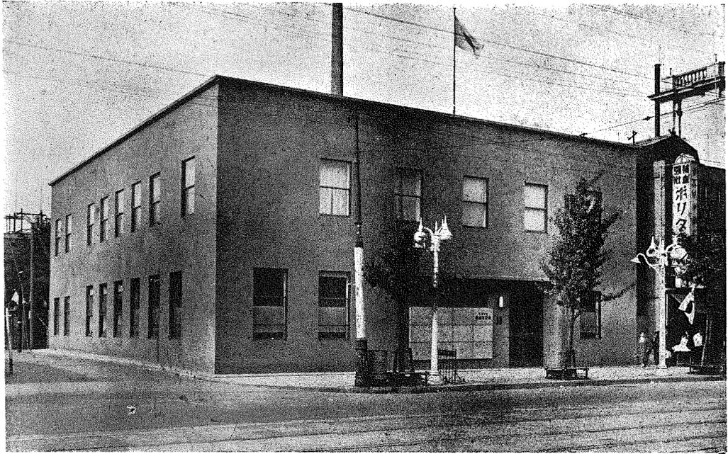
1. 外 観 外装コンクリート打上げ着色セメントスプレー仕上。
