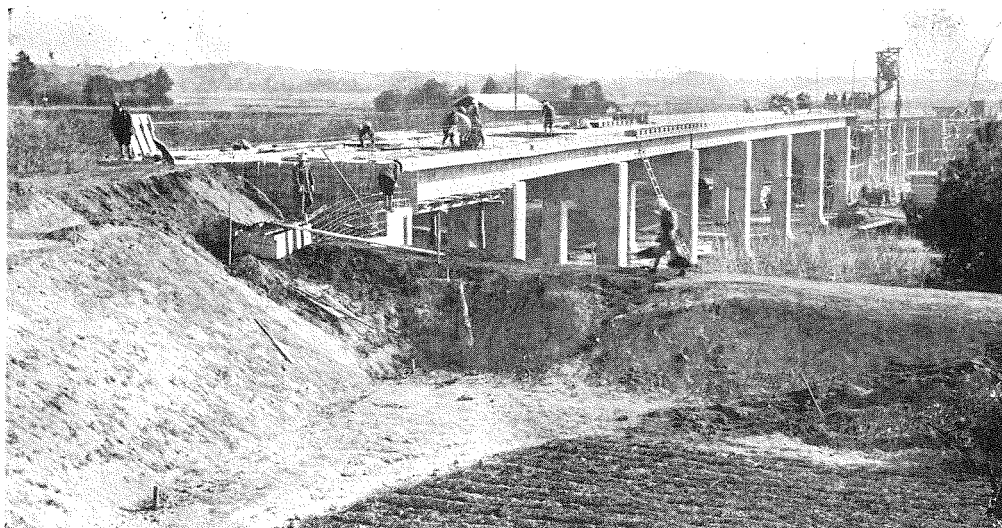
13. 右岸下流より見たる全景。混凝土送達機により橋面舗装及び高欄型枠組立作業。
