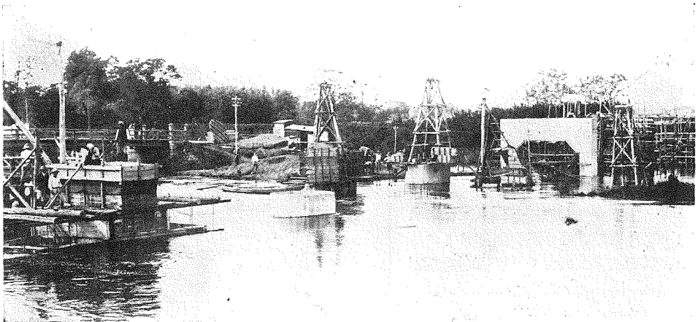
9. 工事中的出水。右方、右岸寄橋脚軀體築造中、左方第2號橋脚上流部井筒耐荷試験。
