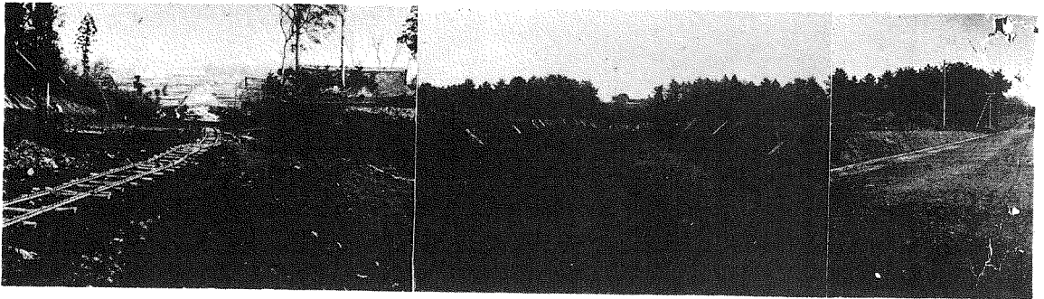
5. 土工完了 (混凝土側溝)
