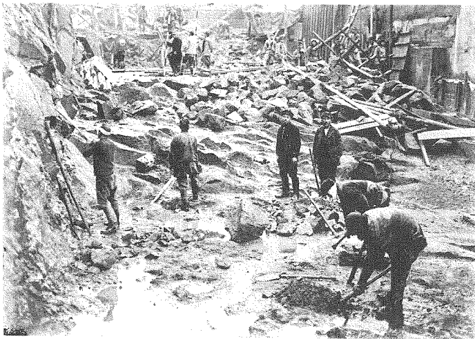
15. 取水堰堤、堰堤右岸 基礎岩盤掘整。(13.12. 13)
