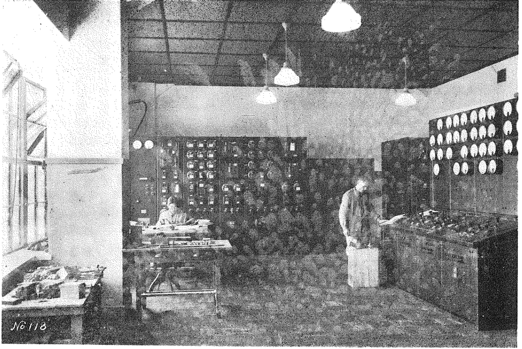
25. 主要変電盤室。(右側は主盤、正面は自動繼電器盤)
