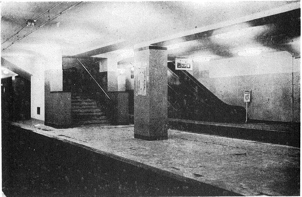
9. 乗降場西端エスカレーター及階段を望む。
