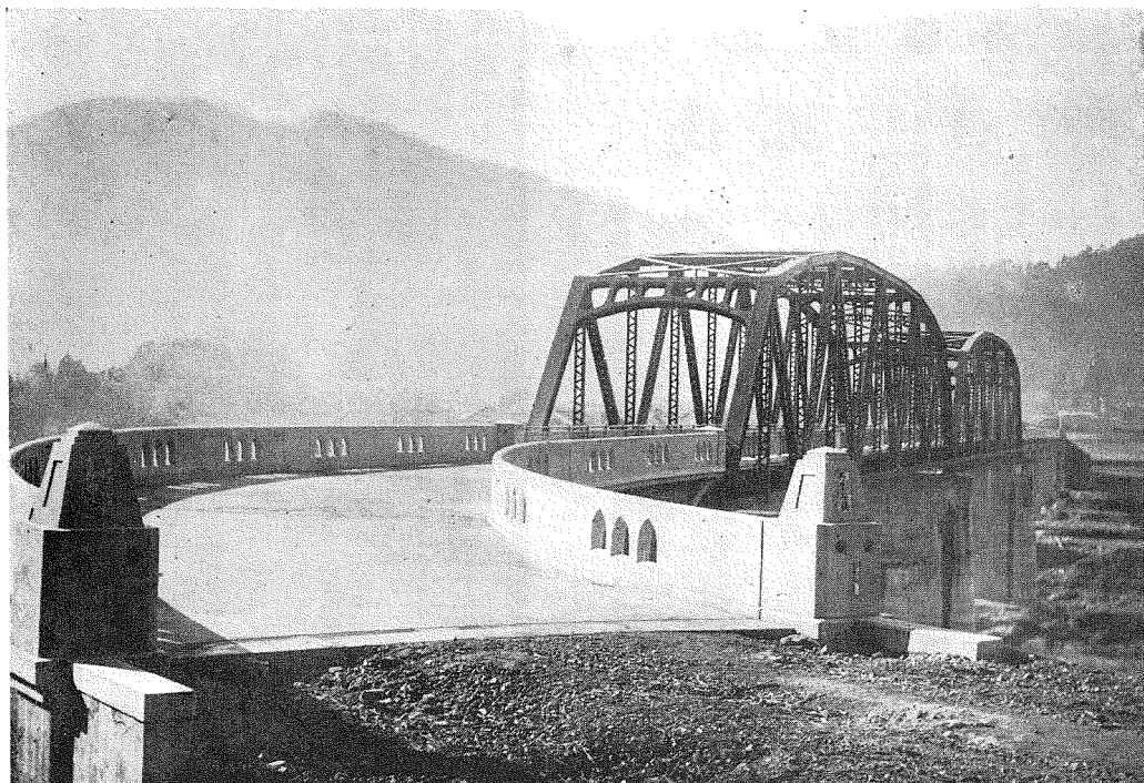
1. 丹生谷橋正面（曲弦桁橋及ワーレントラス）
