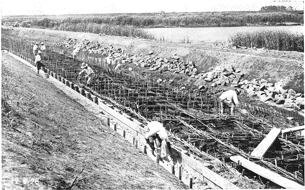
30. 護岸根固め沈床（粗朶）施工状況。
