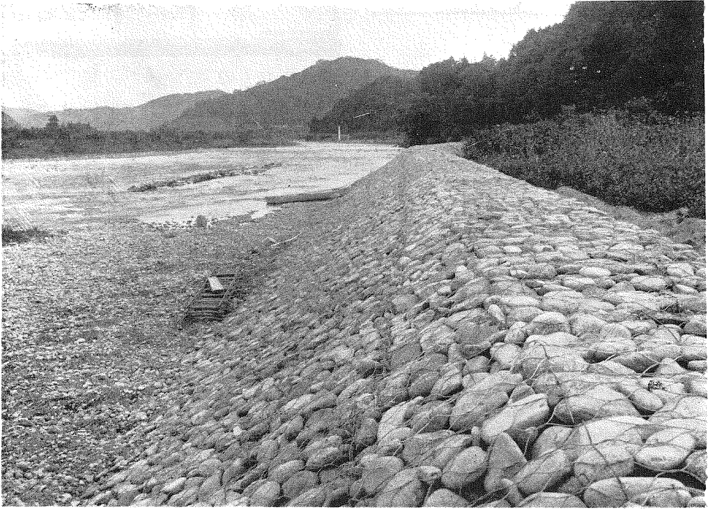
宮川改修工事大橋式蛇籠使用
