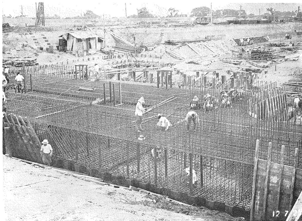
13. 水門基礎版鉄筋配置(継手電気熔接)。
