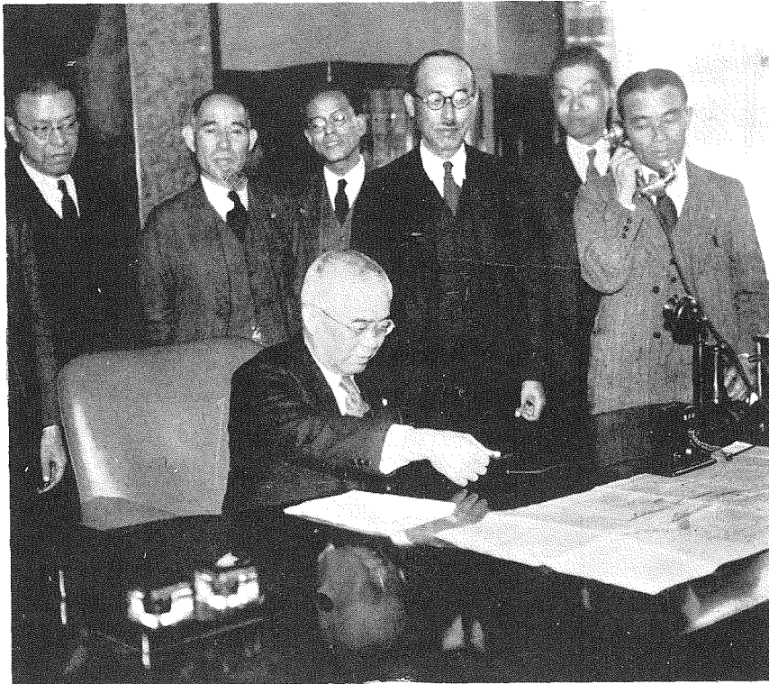
爆破のスイッチを入れるとする前田鐵相 と鐵道省の幹部。
