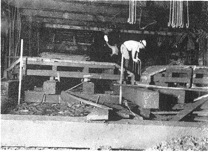
9. 構築上床部分まで掘 鑿完了したので上床鉄筋混 凝土の型枠及鉄筋組立中。
