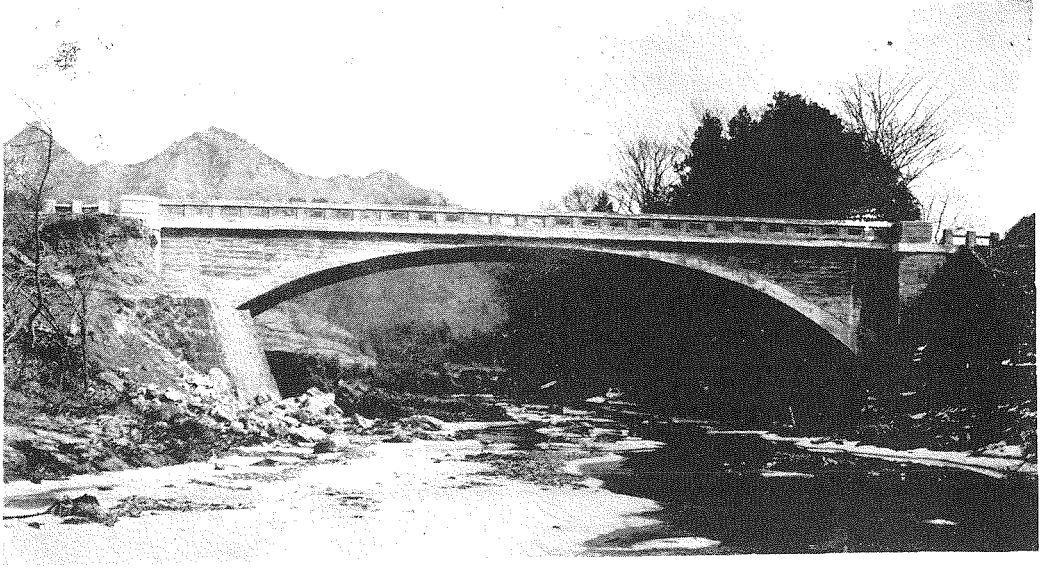
1. 瀧川橋の全景
