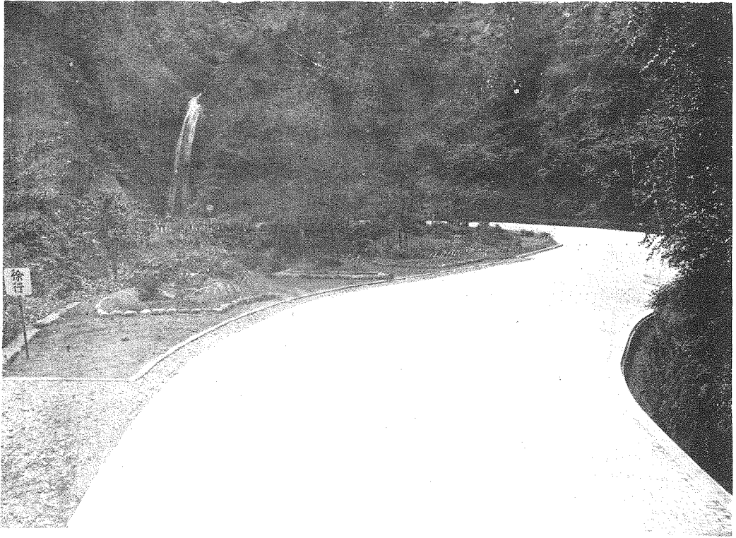
(2) 竣工せる1號國道・神奈川縣足柄下郡溫泉村大字大平臺(蛙の瀧附近)
