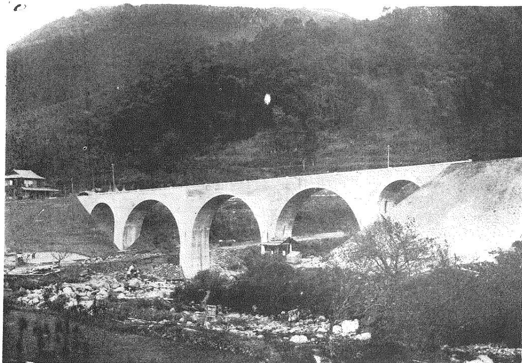
(7) 日田線第四彦山川拱橋 鐵筋コンクリート拱 徑間14米 3連 コンクリート拱 徑間7米 2連 寶珠山、彦山間日田起點29軒 684米
