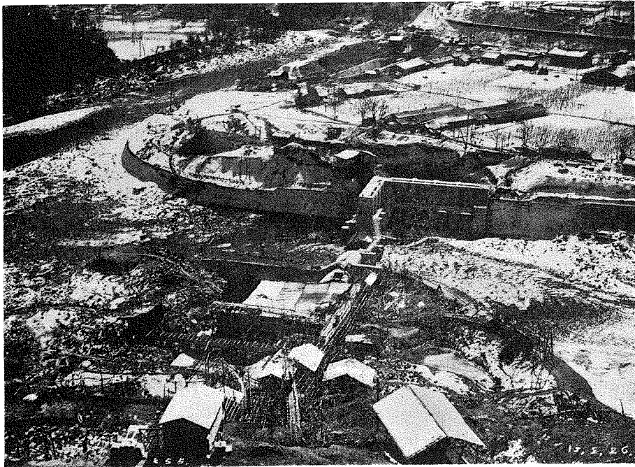
(6) 工事中の王瀧川 隼堰堤及沈砂池を左岸 より望む。
