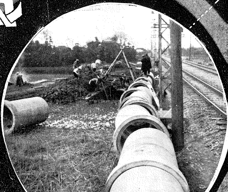
川崎市工場用水道水圧四冠ヒューム管 延長約一萬米 内徑1.000耗, 800耗, 700耗, 600耗
