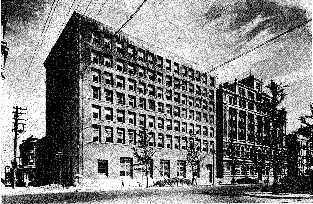
(1) 石貼を除き葺工せる第一期工事全景。
