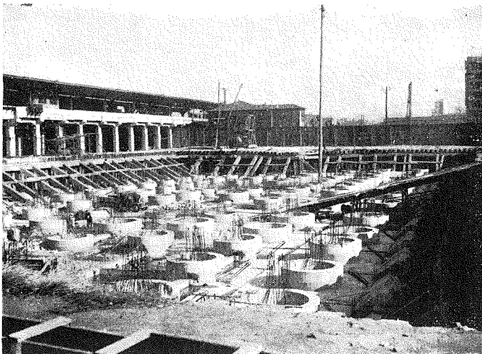
(2) 間式井筒工法による基礎工事。
